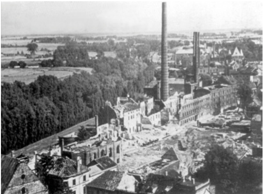
Blick auf das kriegszerstörte Quartier an der Brückstraße in Neuss.
