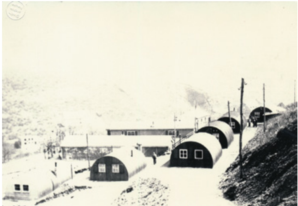
Sogenannte Nissenhütten aus Wellblech, wie hier in Neuss, dienten als Notunterkünfte für Vertriebene.
